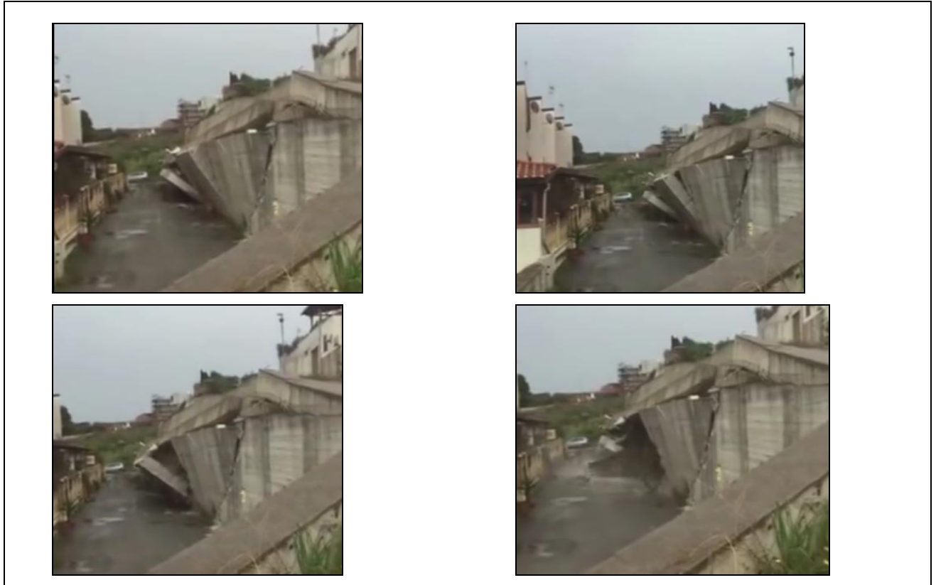
Figura 5 – Fasi del crollo (estratti da video girato dall'ufficio tecnico comunale).
