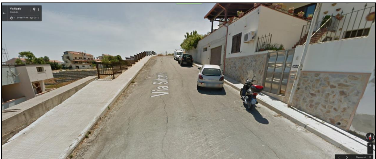
Figura 3 - Stato ex ante - particolare tratto a maggiore altezza (fonte: Google maps).
