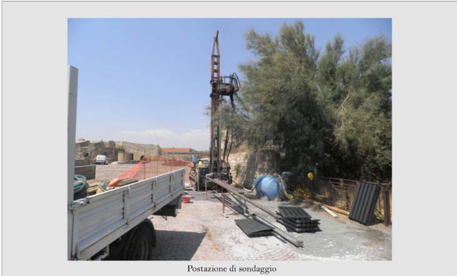
Postazione di sondaggio
