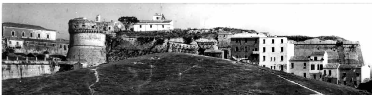
1950 _Crotona Castello, crollo della muraglia tra Torre Comandante e Bastione San Giacomo
