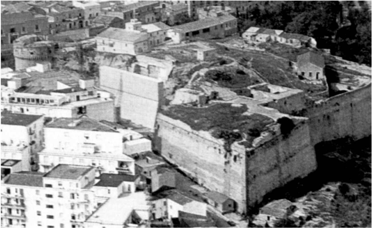
1969_ Il Castello di Carlo V in una foto aerea, la muraglia crollata in fase di ricostruzione
