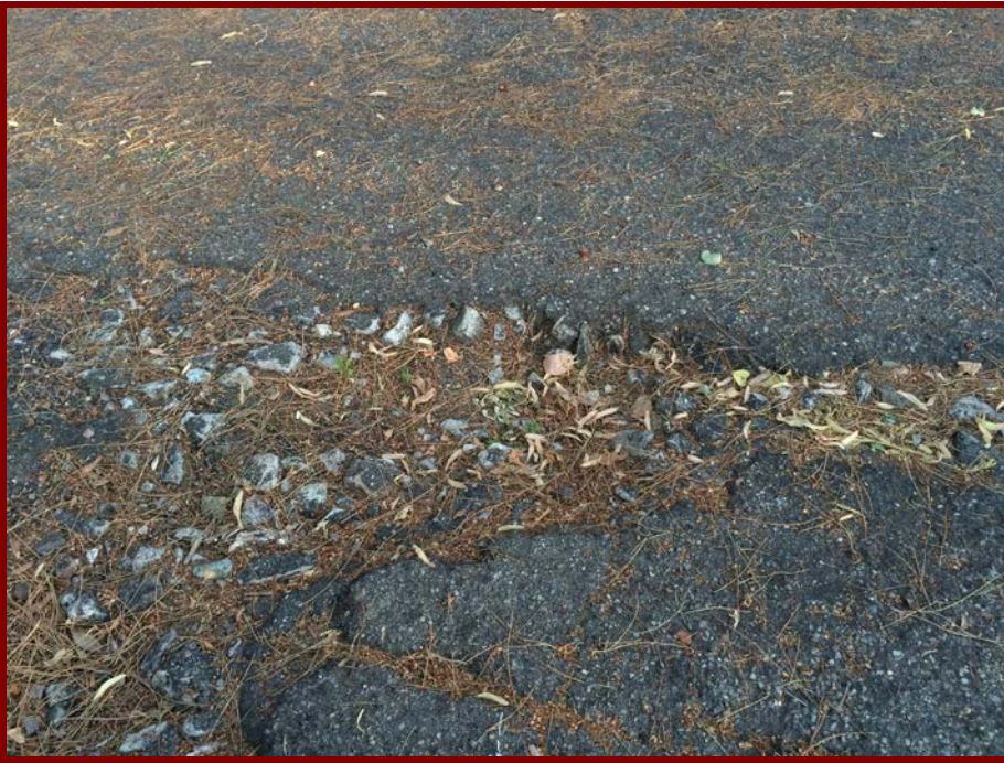
8 - dettaglio dell'attuale stato della pavimentazione
