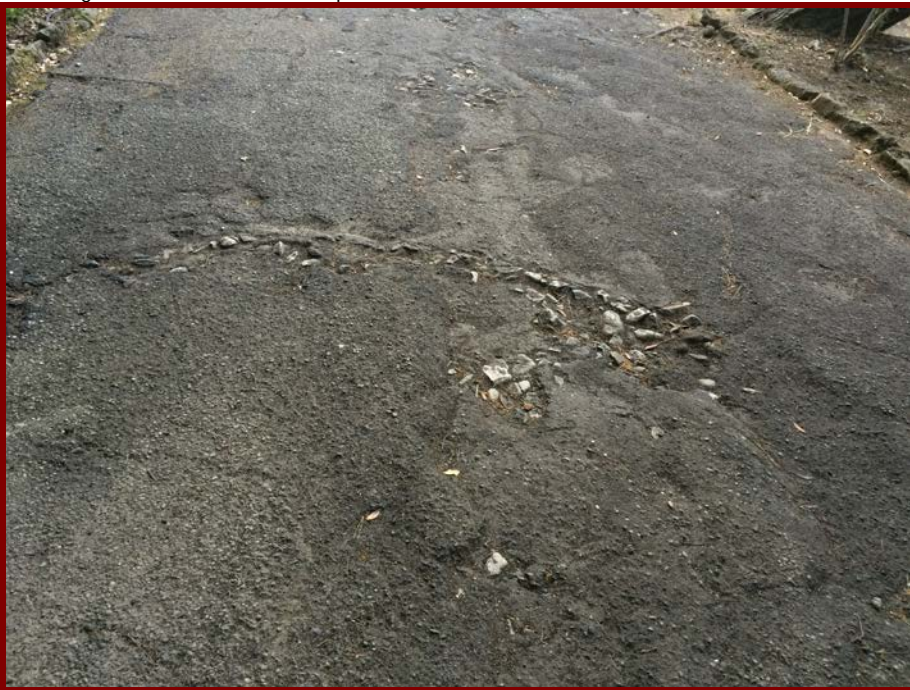
9 - dettaglio dell'attuale stato della pavimentazione
